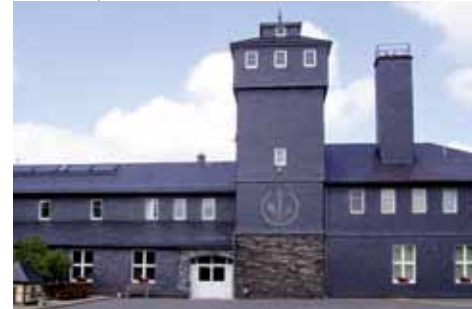
Hauptgebäude der Dachdeckerschule
