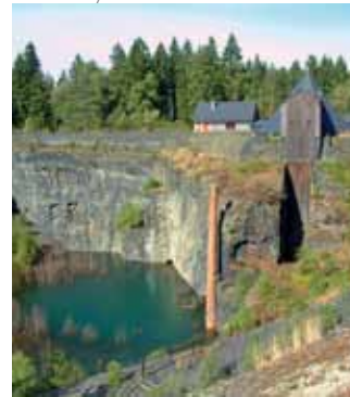
An der Tagebau- rückwand der Göpel- schachtanlage sind die geologischen Schichten des Lehestener Dach- schieferlagers sichtbar.
