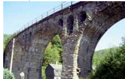
Überspannung des Tales durch Viadukt
