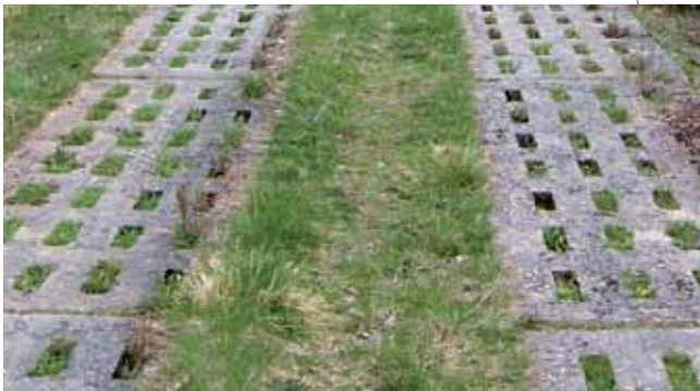
Wabenplatten im Bereich des Kolonnenweges
